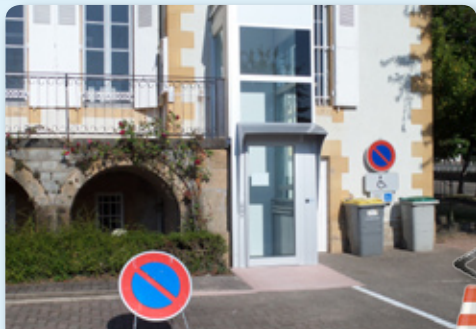
Nouvel Élévateur à la Mairie
