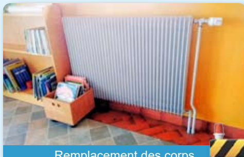
Remplacement des corps des robinets des radiateurs de l'École de Sept-Fons
